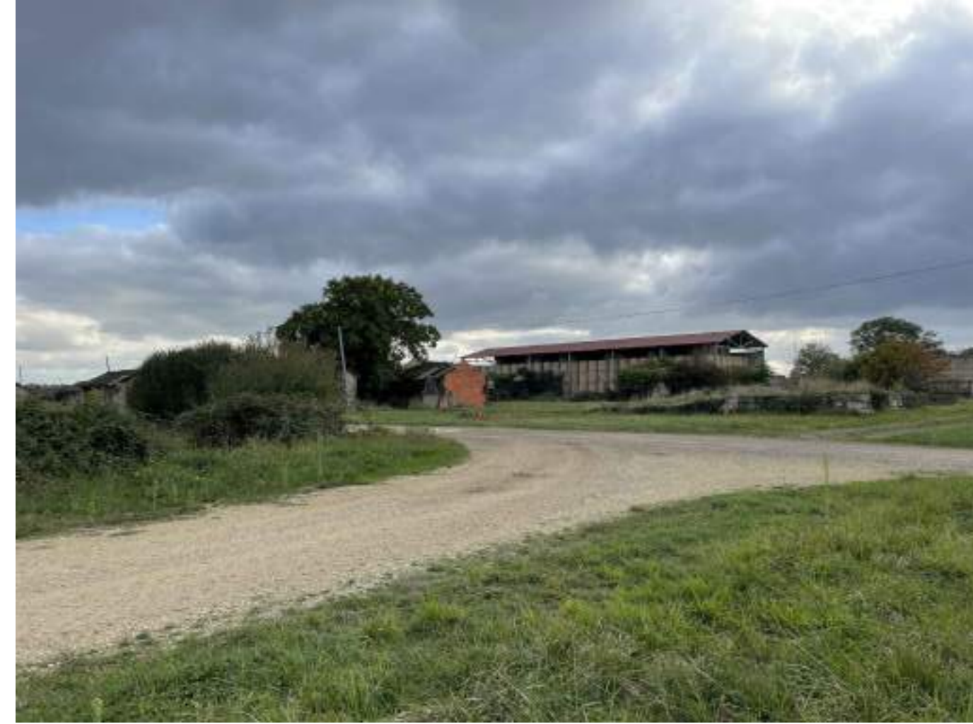
02 Photographie de l'état existant
